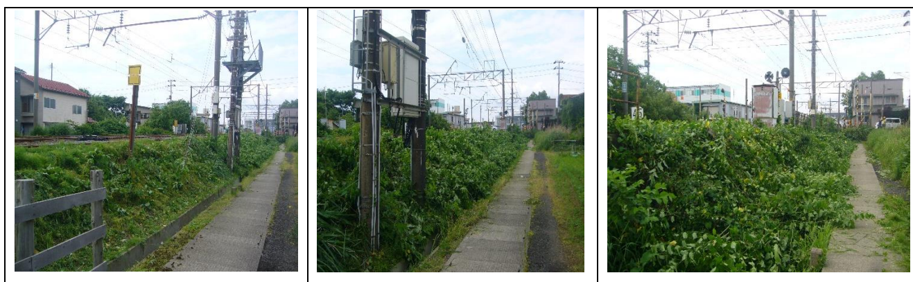
○ 作業終了（本荘街道踏切付近）
